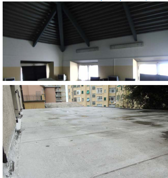
Figura 4.2 - Particolare delle coperture (falda scuola dall'interno di un'aula e piana palestra)
