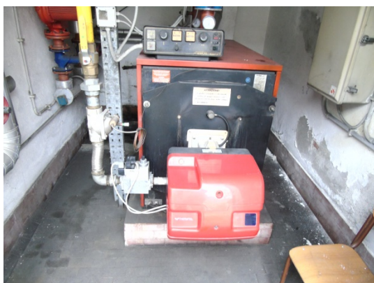
Figura 4.11 - Generatore di calore
